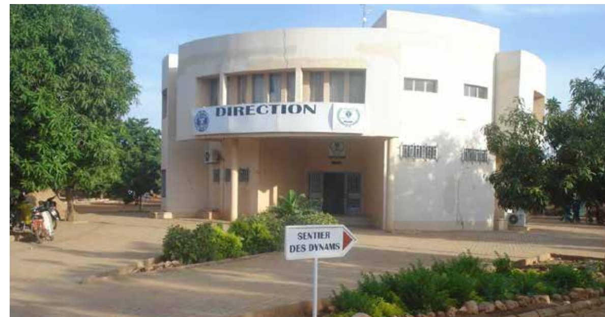
Image 1 | Bâtiment abritant des services de la direction de l'École nationale de police
