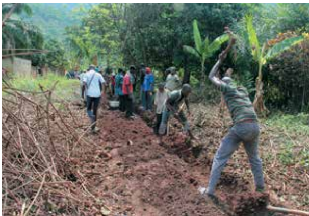
Mobilisation de la population de la localité d'Agou Nyogbo Agbétiko (Togo) pour la construction d'une mini-adduction d'eau. Projet financé dans le cadre du Profadel, 2013. © DR
